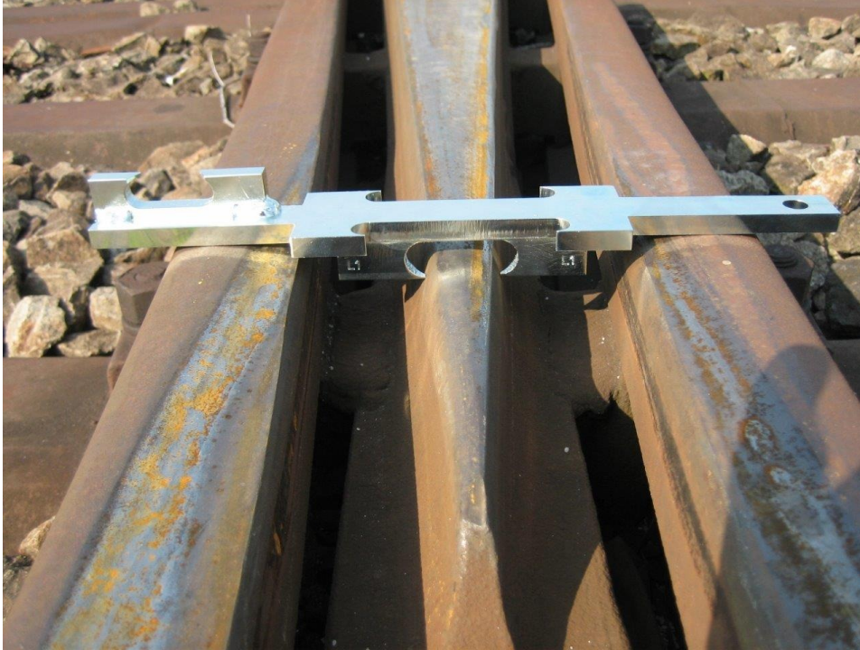
Sahada makas göbeği üzerinde L / L1 ölçüm mastarı uygulaması
